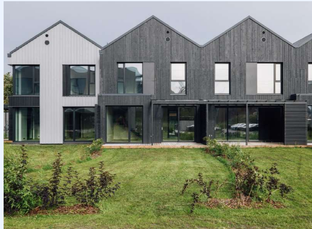
Iseära ridaelamud. Arhitekt: ARS Projekt
